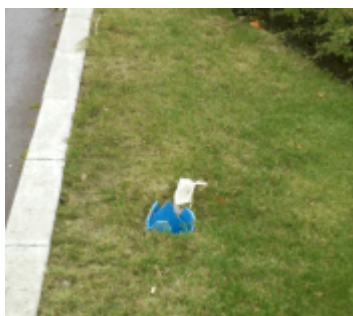
Åben boring med ødelagt rørtop
